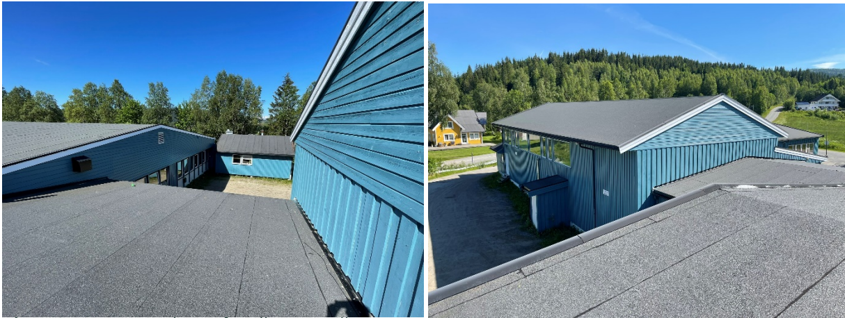
Figur 9: Venstre: Tak sett fra tilbygg mellom hovedbygg og gymsal. Høyre: Tak sett fra hovedbygg mot gymsal.
