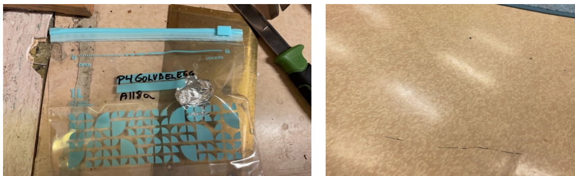
Bilde B4: P4 Beige vinyl gulvbelegg (ett lag). Bilder fra A118a Kopirom og A137 Klasserom.
