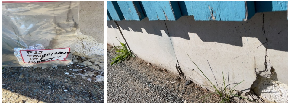
Bilde B25: P25 Fasadeplater mot bakken. SFO/Samfunnshus, utvendig.
