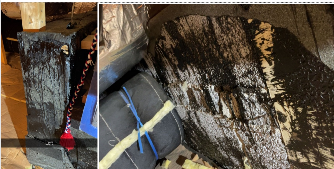
Bilde B12: P12 Svart papp på gulv. Kryploft over hoveddel.
