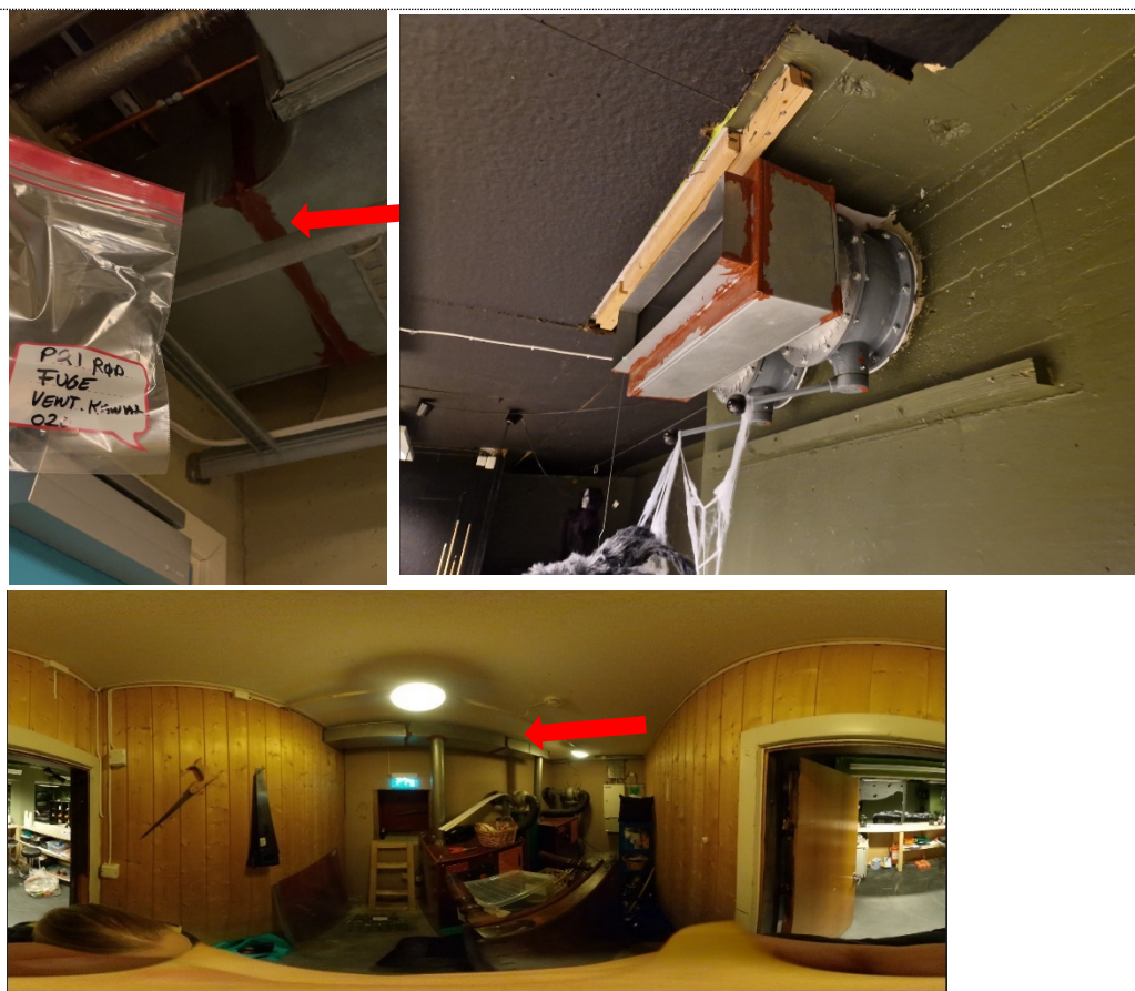
Bilde B21: P21 Rød fuge rundt ventilasjonskanal. Bilder fra Gymsal Plan U 020 Teknisk rom, 019 tilfluktsrom, og 018 Aggregat.
