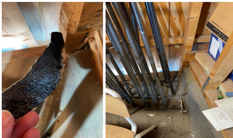
Bilde B12: P12 Svart papp på gulv. Kryploft over hoveddel.
