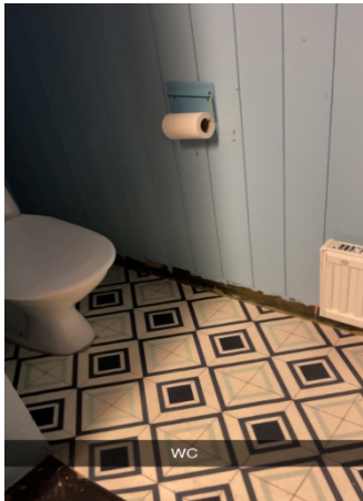
Bilde B41: Innkassing i Plan U Gymsal 016 WC - kan inneholde asbest. Ikke prøvetatt.
