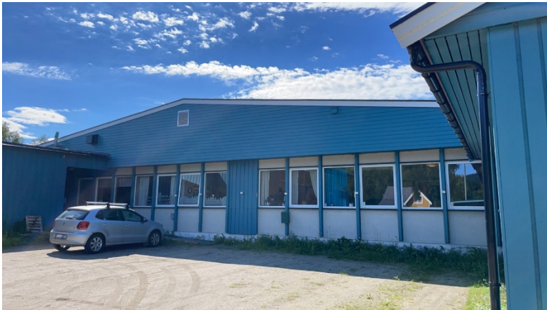
Figur 6: Nordvendt fasade hovedbygg. Tilbygg tilstøtende gymsal til venstre, lærerrom/brakke til høyre i bildet.
