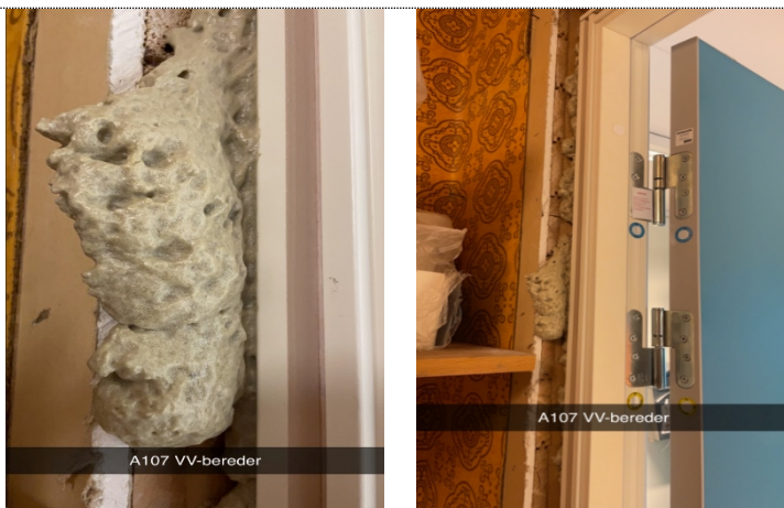
Bilde B39: Byggeskum som kan inneholde KFK/HKFK. A107 VV-bereder. Ikke prøvetatt.
