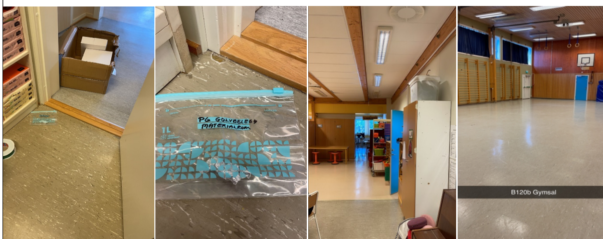
Bilde B6: P6 Vinyl gulvbelegg. Bilder fra A120a Materialrom, A137 Klasserom, og B120 Gymsal.
