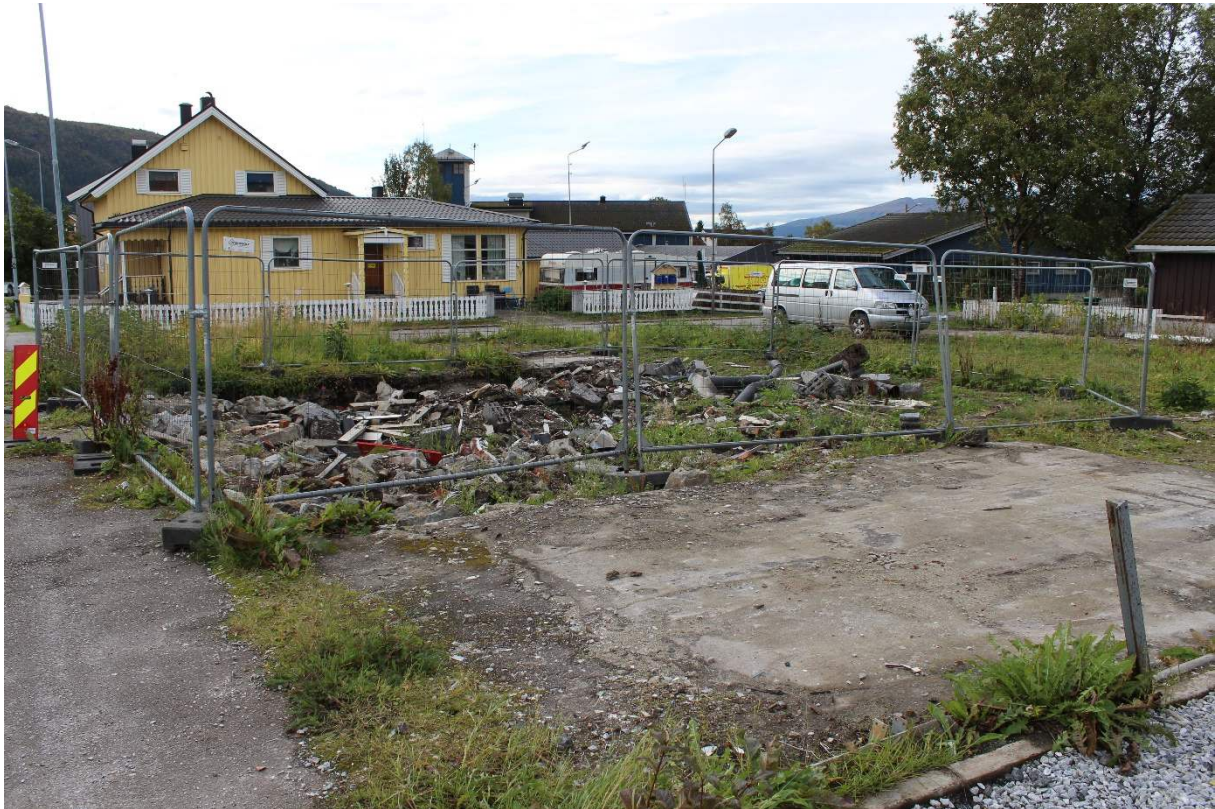
Figur 5: Nordlandsveien 41 etter rivning. Bilde tatt fra Nordlandsveien.
