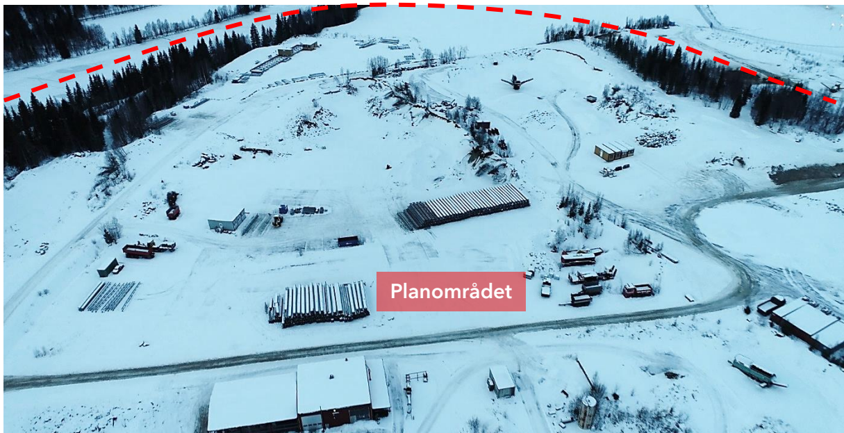
Figur 9: Dronebilde fra planområdet, tatt 10.12.21, fra øst/sørøst. Viser lagring av materiell, utstyr og noen brakker.
