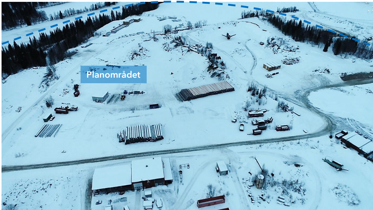
Dronebilde fra planområdet, tatt 10.12.21, fra øst/sørøst. Viser lagring av materiell, utstyr og noen brakker.
