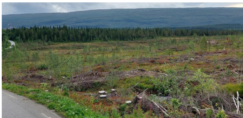
Figur 6. Det har allerede vært gjennomført anleggsarbeid i planområdet ved at skogen er hugget ned og kjørt bort. Foto: Svein Morten Eilertsen, 19/8-2022.
