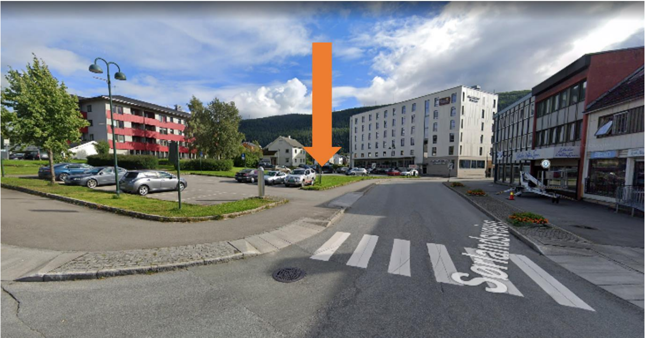
Figur 2-3: Planområdet sett fra Kirkegata, eksisterende Helma hotell skal beholdes og tilkobles nytt bygg (illustrasjon hentet fra Google.no/maps)
